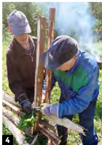
1. Uusi riukuaita komistaa perinnumaisemaa 2. Valmis riukuaita Knaappilan tuulimyllyn edustalla 3. Aatami Lehtimäki sitomassa vitsaksia 4. Aatami Lehtimäki ja Heikki Iso-Kuortti sitomassa vitsaksia 5. Veikko Toivakka aisaa riukua 6. Merja Nurminen hiillostamassa aitatolppia
