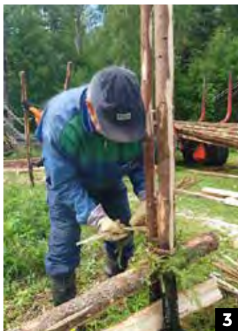
1. Uusi riukuaita komistaa perinnumaisemaa 2. Valmis riukuaita Knaappilan tuulimyllyn edustalla 3. Aatami Lehtimäki sitomassa vitsaksia 4. Aatami Lehtimäki ja Heikki Iso-Kuortti sitomassa vitsaksia 5. Veikko Toivakka aisaa riukua 6. Merja Nurminen hiillostamassa aitatolppia
